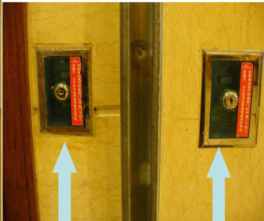
防火卷帘 两侧手动控制按钮
